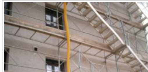
Dachdecker von Dach gestürzt (Archivfoto einer Baustelle)
